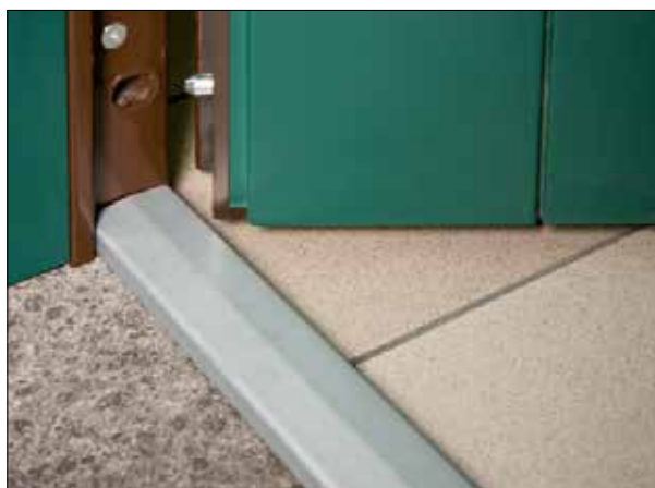
BATTUTA SOTTO IN LUCE BATTUTA*** IN ALLUMINIO N54x20 (vedi schede tecniche pag. 226)
