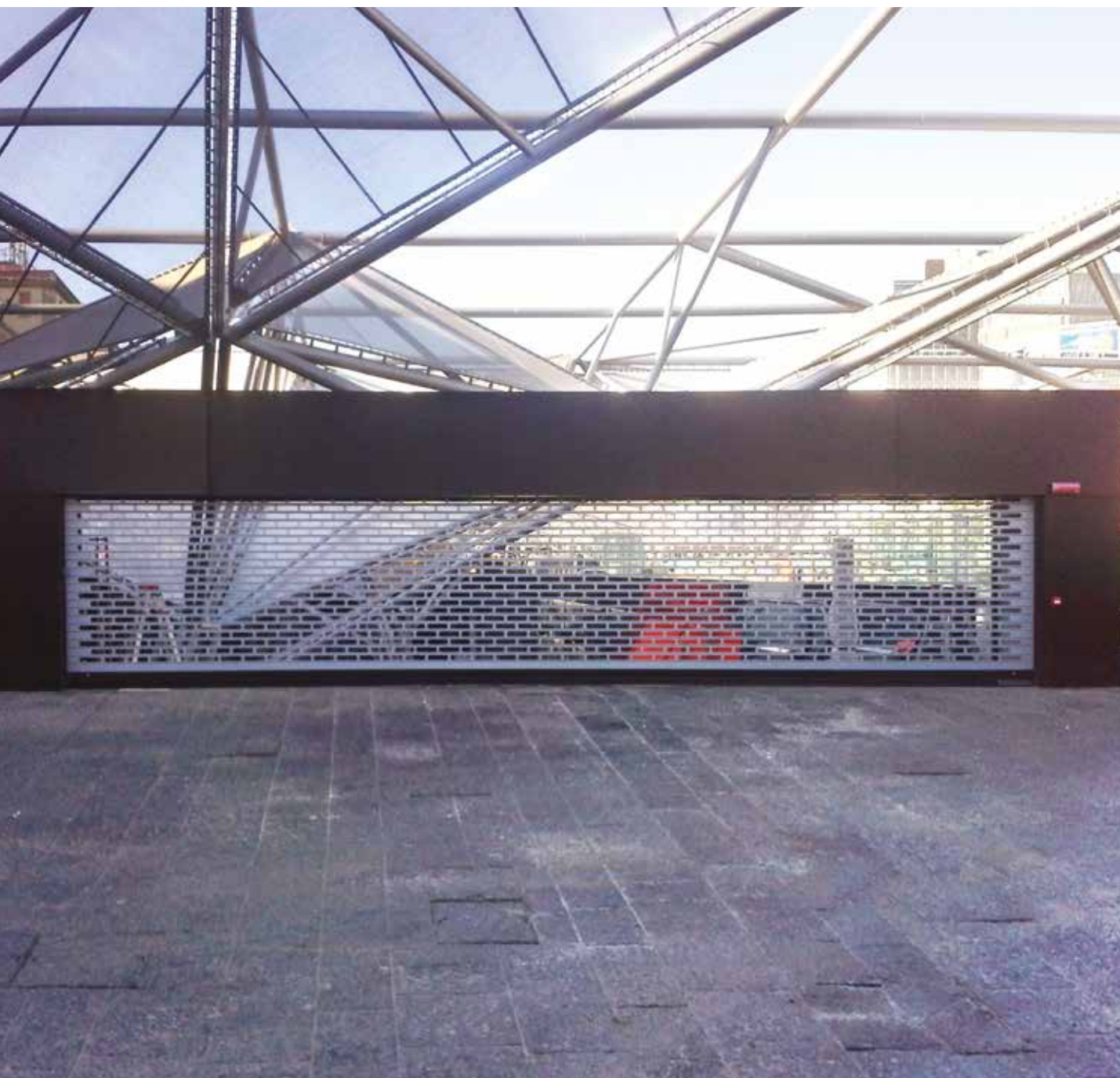
Serranda DOMINUS SFAS asolata sfalsata verniciata colore RAL Grigio 9006 per l'ingresso di una metropolitana.
